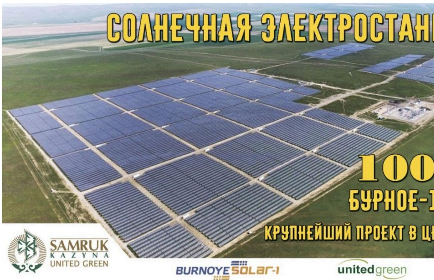
25 апреля исполняется пять лет одной из самых крупных в Центральной Азии солнечных электростанций «Бурное-1» мощностью 50 МВт, расположенной в Жамбылской области. На станции установлено 192 192 фотоэлектрических модуля, которые занимают площадь 150 га в Жуалынском районе.
